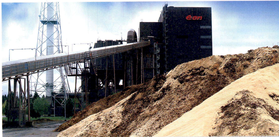
Unkarin Pécsissä sijaitsee 145 MWth:n sähköä ja lämpöä tuottava laitos, joka on toiminut moitteettomasti runsaan vuoden. Kvaerner Power modernisoi laitoksen hiiltä polttavan kattilan biopolttoaineita käyttäväksi. Kuva: Kvaerner Power Oy
