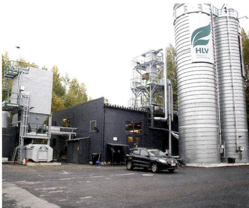
22 Pelletti on tuttua energiaa Hyvinkäällä
