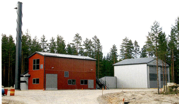
↑ Olemassa oleville laitoksille 5 – 50 MW on erilaisia määräaikaista poikkeuksia, jotka vaikuttavat päästöraja-arvoihin ja päästöjen mittaamiseen. Kuva Nakkila Boilers
