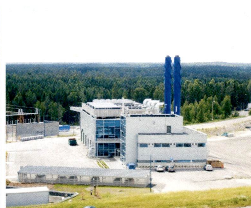
32 Biokaasu on HSY:lle merkittävä energianlähde
