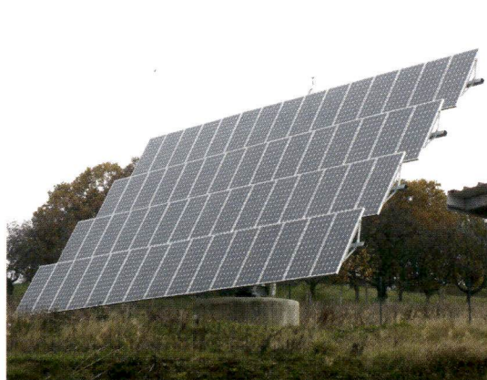
18 Oma sähkö kultan kallis
