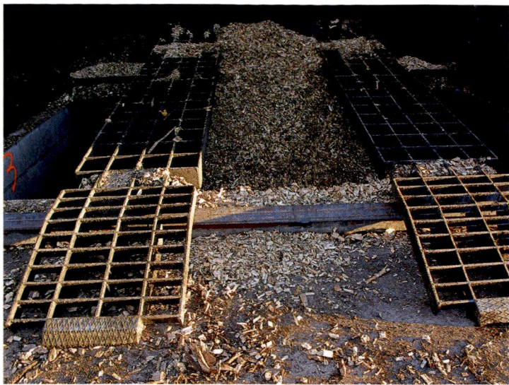
↑ Ajorampit asennettiin jälkikäteen, kun huomattiin, että hake ei valutukaan peräseinälle asti.
