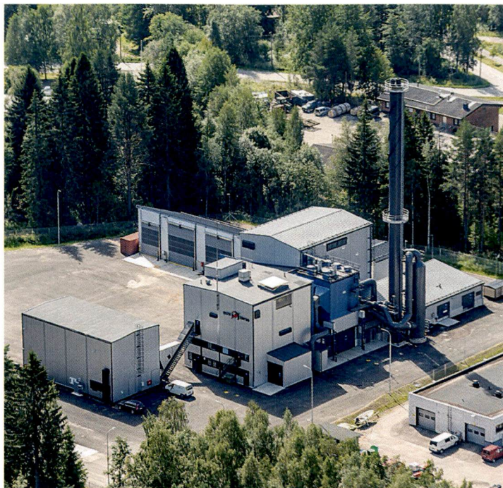
↑ Leppävirran biolämpökeskuksessa on kattilatehoa 8 ja 5,5 megawattia ja lisäksi 2 megawattia savukaasujen lämmön talteenottoa.
