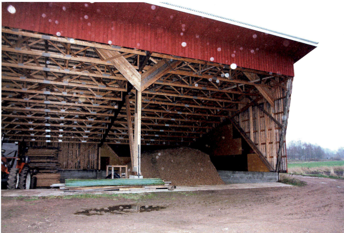
Polttoainetta varastoidaan kahteen paikkaan. Se haketetaan suoraan katettuun lantalaan, josta se ajetaan lämpökeskukselle 400 metrin päähän. Tankopurkainten päälle mahtuu enimmillään noin 150 hakekuutiota, lattialle ja varastokuivurin laareihin muutama sata lisää.
