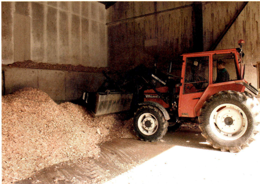
Varastoon mahtuu runsas 200 kuutiota. Sen nurkassa, tankopurkaimen päällä oleva tasku on sen verran pieni, että haketta on siirreltävä peremmälle etukuormaimella suunnilleen puolen toista viikon välein
