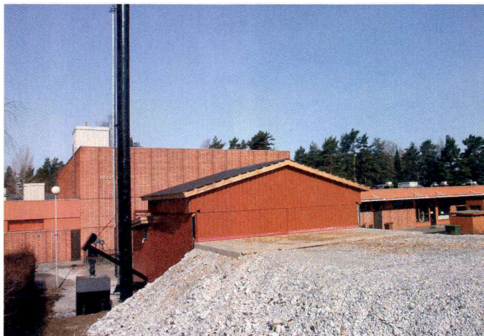
Nojanmaan koulun lämpökeskuksen hakevarastoon mahtuu 70 kuutiota polttoainetta, joka riittää kuudesta vuorokaudesta reiluun kahteen viikkoon. Katto on liukukiskojen varassa.
