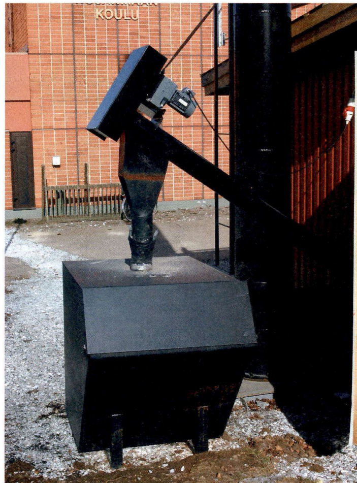
Nojanmaan koulun lämpökeskuksen hakevarastoon mahtuu 70 kuutiota polttoainetta, joka riittää kuudesta vuorokaudesta reiluun kahteen viikkoon. Katto on liukukiskojen varassa
