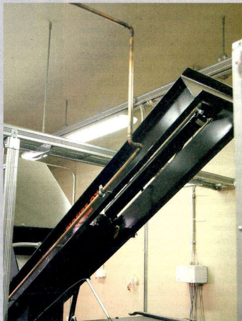
Nojanmaan koulun lämpökeskuksen hakevarastoon mahtuu 70 kuutiota polttoainetta, joka riittää kuudesta vuorokaudesta reiluun kahteen viikkoon. Katto on liukukiskojen varassa
