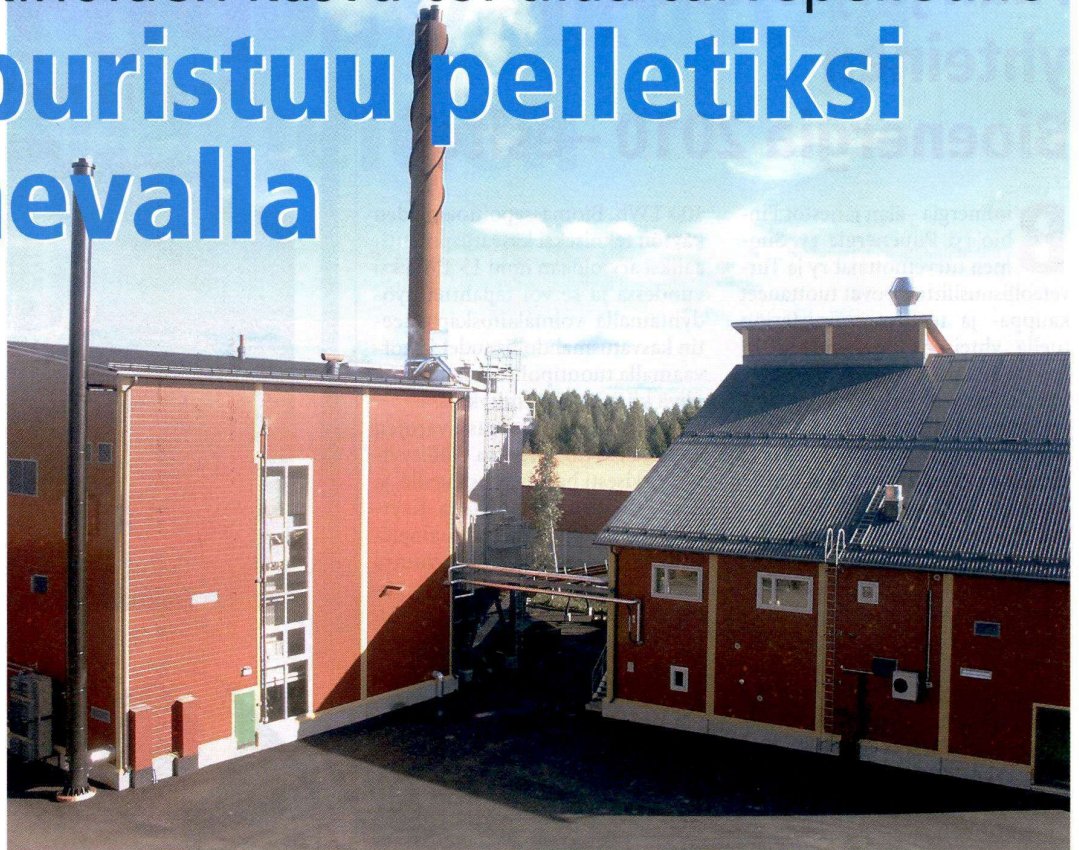
Haukinevan pellettitehtaasta tekee ainutlaatuisen vasemmassa rakennuksessa sijaitseva kuivuri, joka mahdollistaa turpeen ja esimerkiksi ruokohelpin käyttämisen pelletin raaka-aineena.
