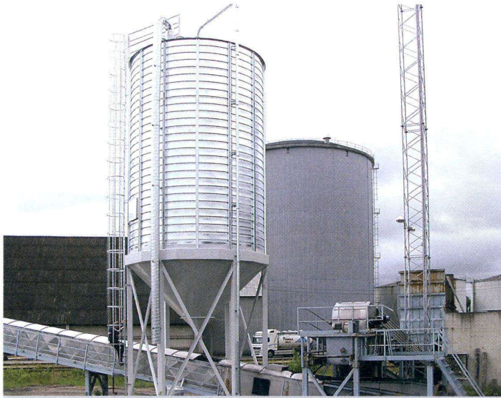
Yksi käyttökohde sekä turve- että puupelleteille on polttoaineen priimaus voima- ja lämpölaitoksissa. Tähän erityinen Priimaussiilo tarjoaa automaattisesti toimivan mahdollisuuden.
