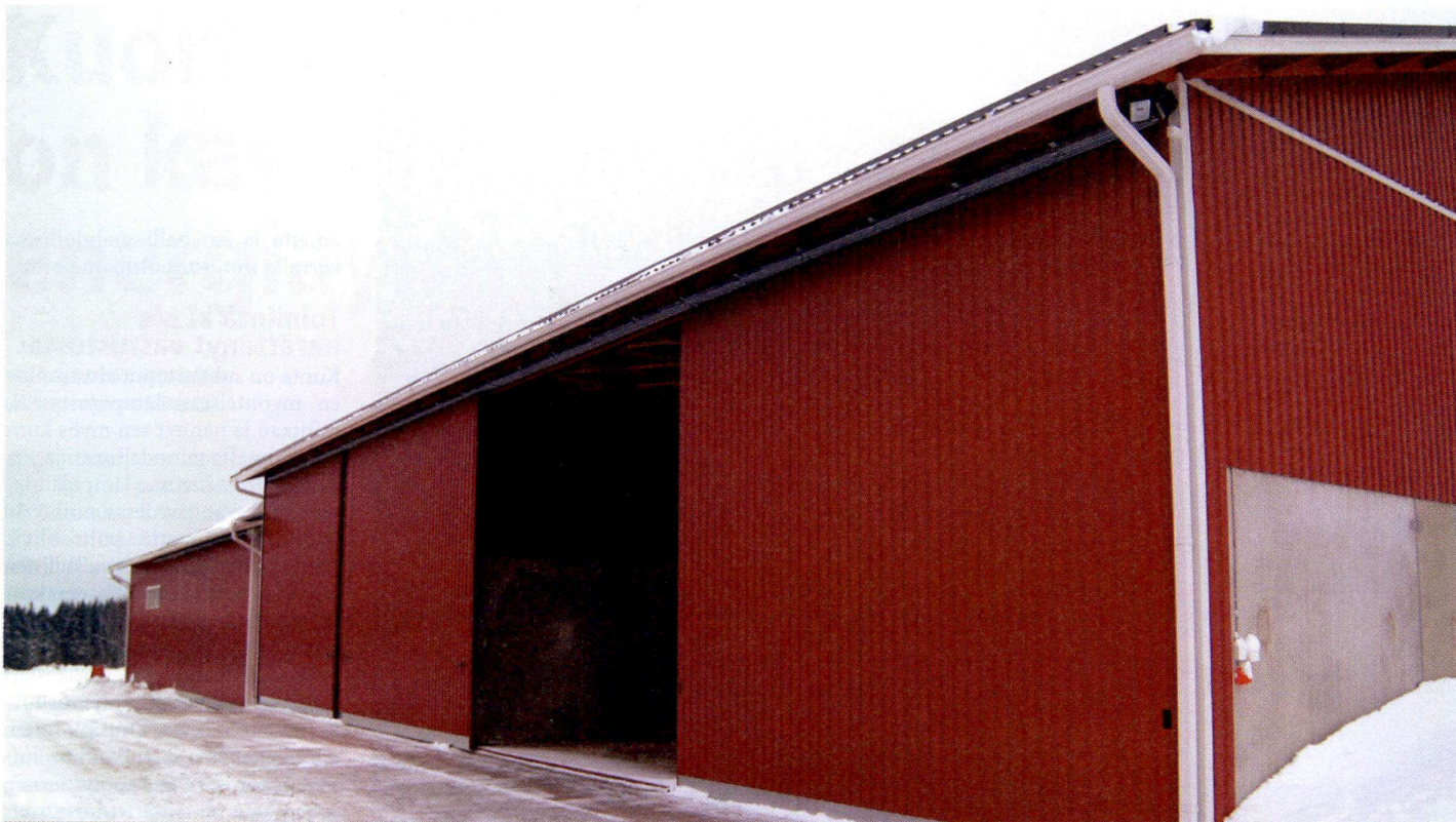
Lujabetonin siiolementeistä tehty polttopuukuivuri on kytketty vanhan, vielä puhallusperiaatteella toimivan kuivurin jatkeeksi ja sen neljään siiloon mahtuu 700 mottia pilkkeitä. Uusi osa maksaa noin 50 000 euroa ja vanha osa noin 30 000 euroa ilman arvolisäveroa. Kuivauspinta-alaa on 430 neliötä.
