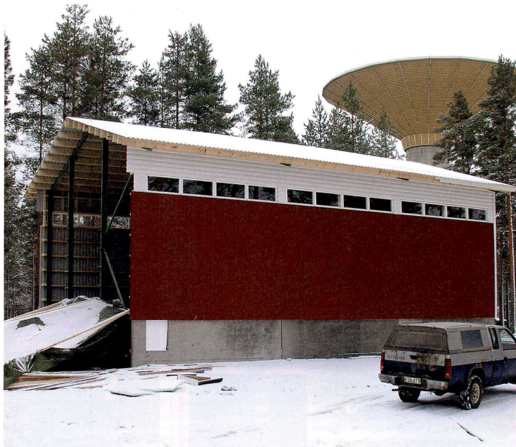
Kortesmäen 1 MW:n laitoksen hakevarastoon mahtuu 200 m 3 haketta, joka riittää pakkasillakin noin viikon käyttöön. Kunnalta ostettuun varastohalliin voidaan haketta varastoida vielä enemmän.
