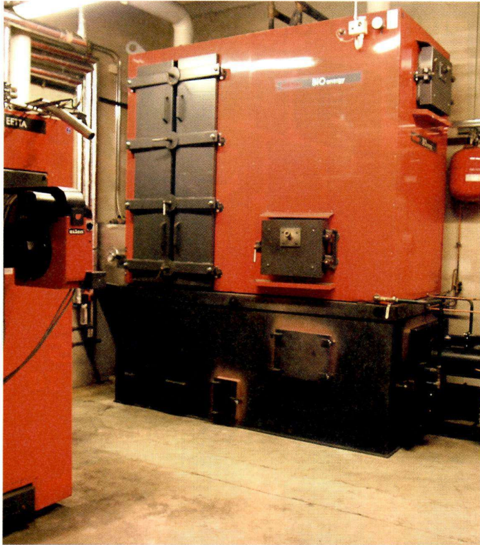
Pelletti- ja öljykattilan yhteisteho on noin 1,15 MW. Öljyn osuutta lisäämällä kasvihuonetta on mahdollisuus edelleen laajentaa.
