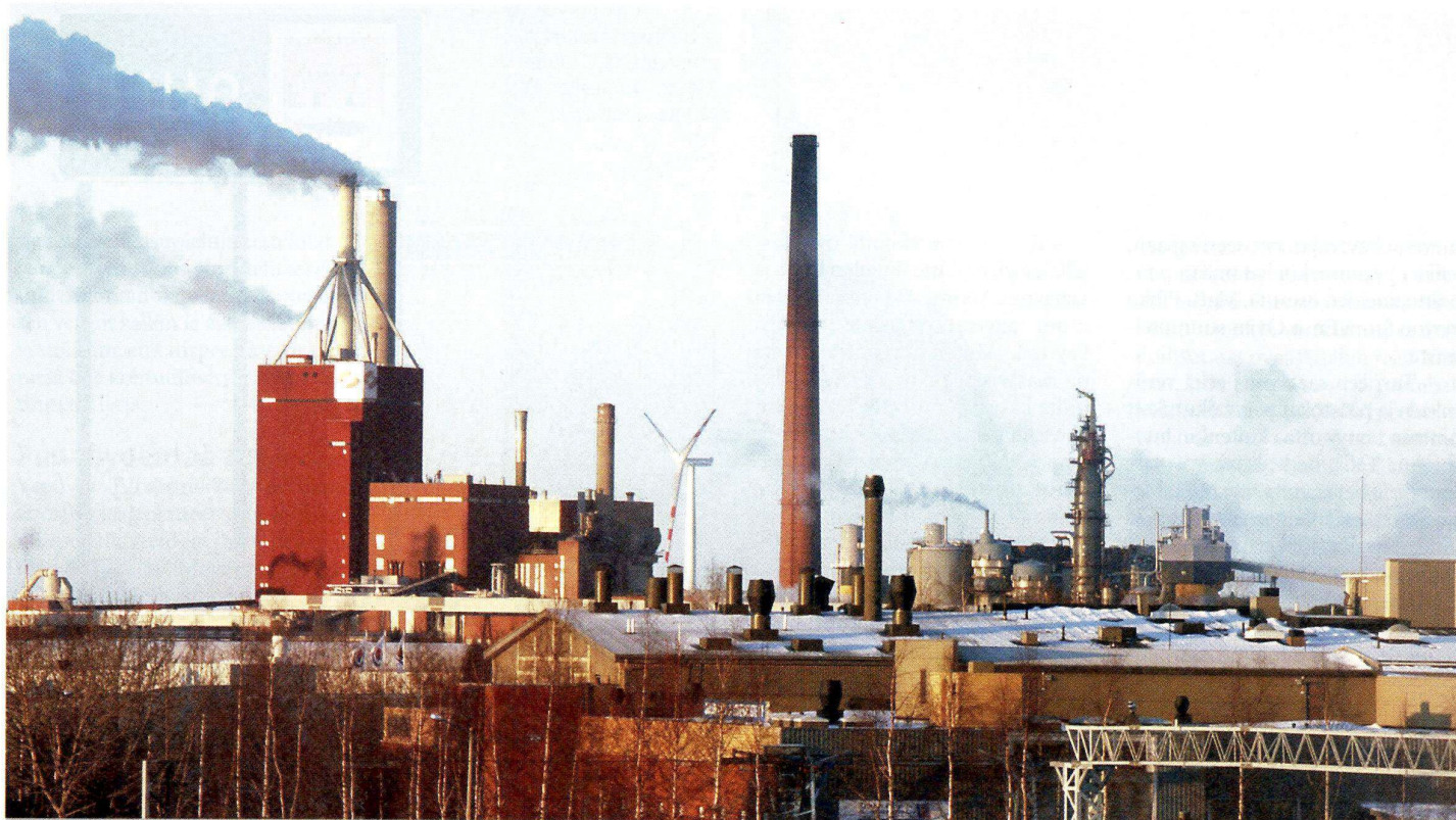
Stora Enson Oulun tehtaiden voimalaitoksella polttoaineena käytetään ennen kaikkea sellutehtaalta saatavia sivutuotteita. Turve on tärkein ulkopuolelta tuleva polttoaine.
