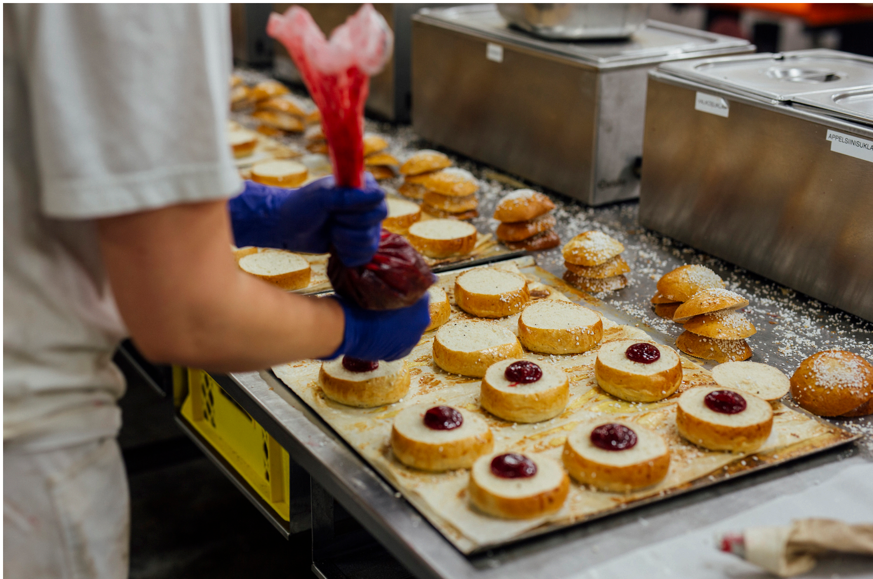
↑ Leipomotilat lämpenevät ja viilenevät maalämpöjärjestelmällä.
