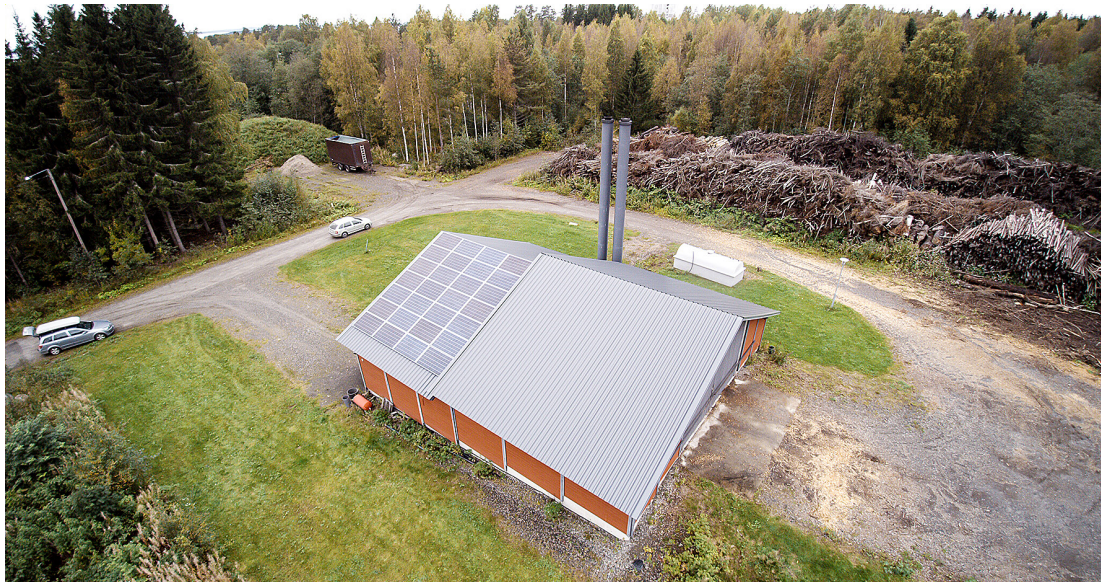
↑ Useilla lämpölaitoksilla on investoitu aurinkosähköjärjestelmiin viime vuosina. Kuva Kontiolahdelta.
