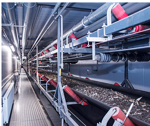
8 Kaukolämmöllä hiilineutraaliksi – sitten hiilinegatiiviseksi
