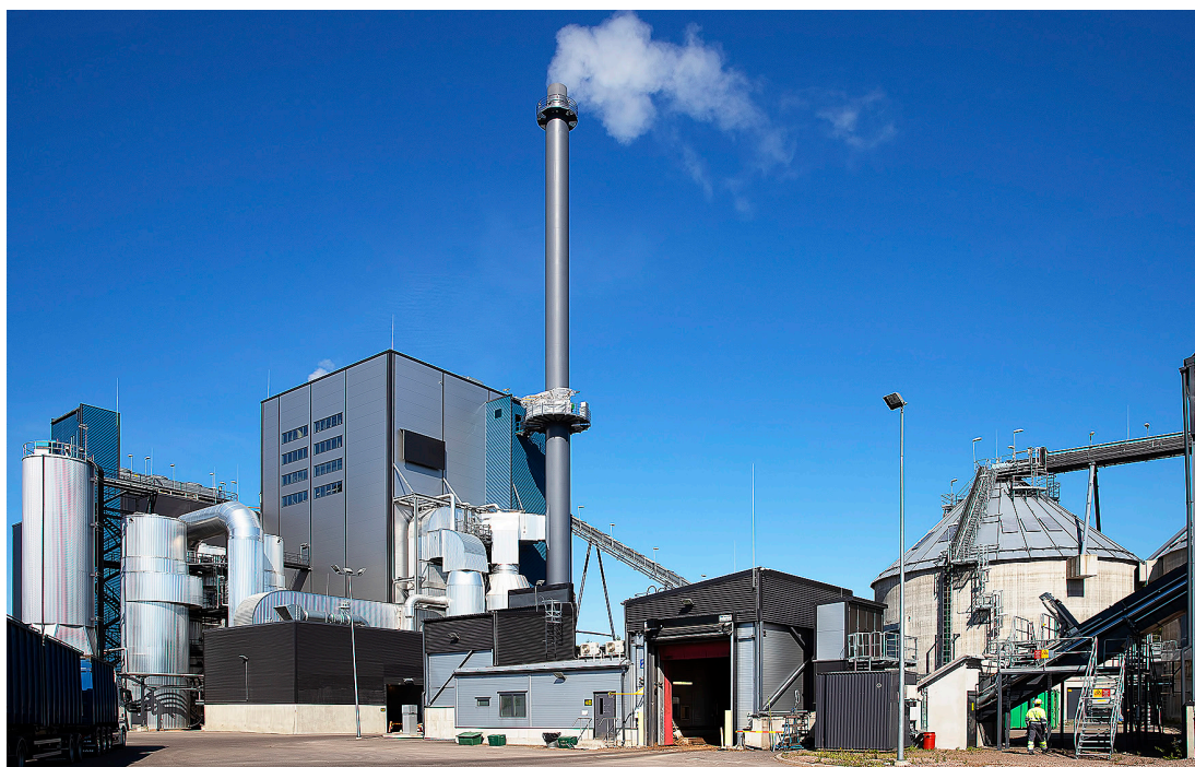
↑ Demonstrointi tehtiin Vantaan Energia Keski-Uusimaa Oy:n Järvenpään voimalaitoksella.
