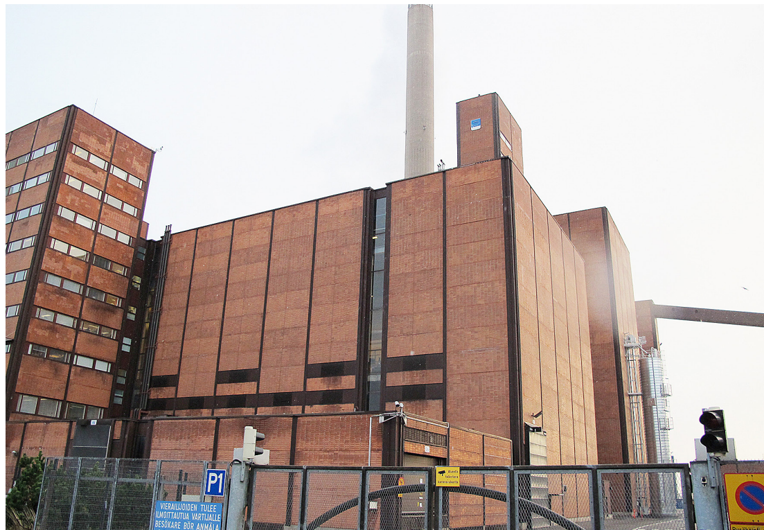
↑ Loppukäyttöihin kohdistetaan uusia ankaria päästövähennysvaatimuksia. Hanasaaren voimalaitosta korvaavien uusien yksiköiden tulee täyttää direktiivin päästövähennysvaatimukset.
