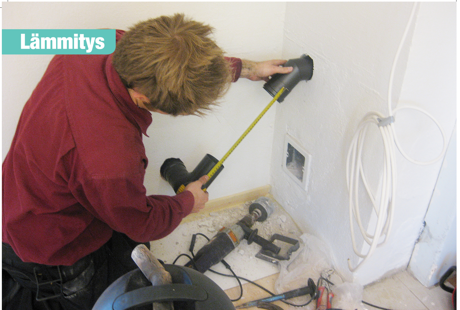
↑ Pellettitakan asennustöitä. Kuva: Kardonar Oy.
