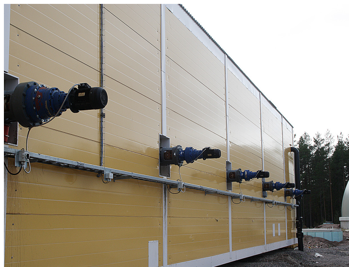
Hankkeessa tuli iso hidaste, ➔ kun laitoksen rakentamisen aloittanut toimittaja teki konkurssin. Valmiina oli vasta reaktorin runko. Se oli todella harmi, sillä rahaa meni hukkaan. Toisaalta laitos on saatu nyt rakennettua vielä paremmaksi, kuin se olisi ollut.
