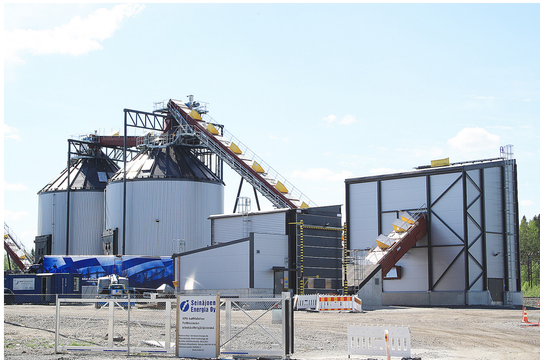
↑ Polttoaineen vastaanotto ja käsittely-yksikkö on lähes valmis.
