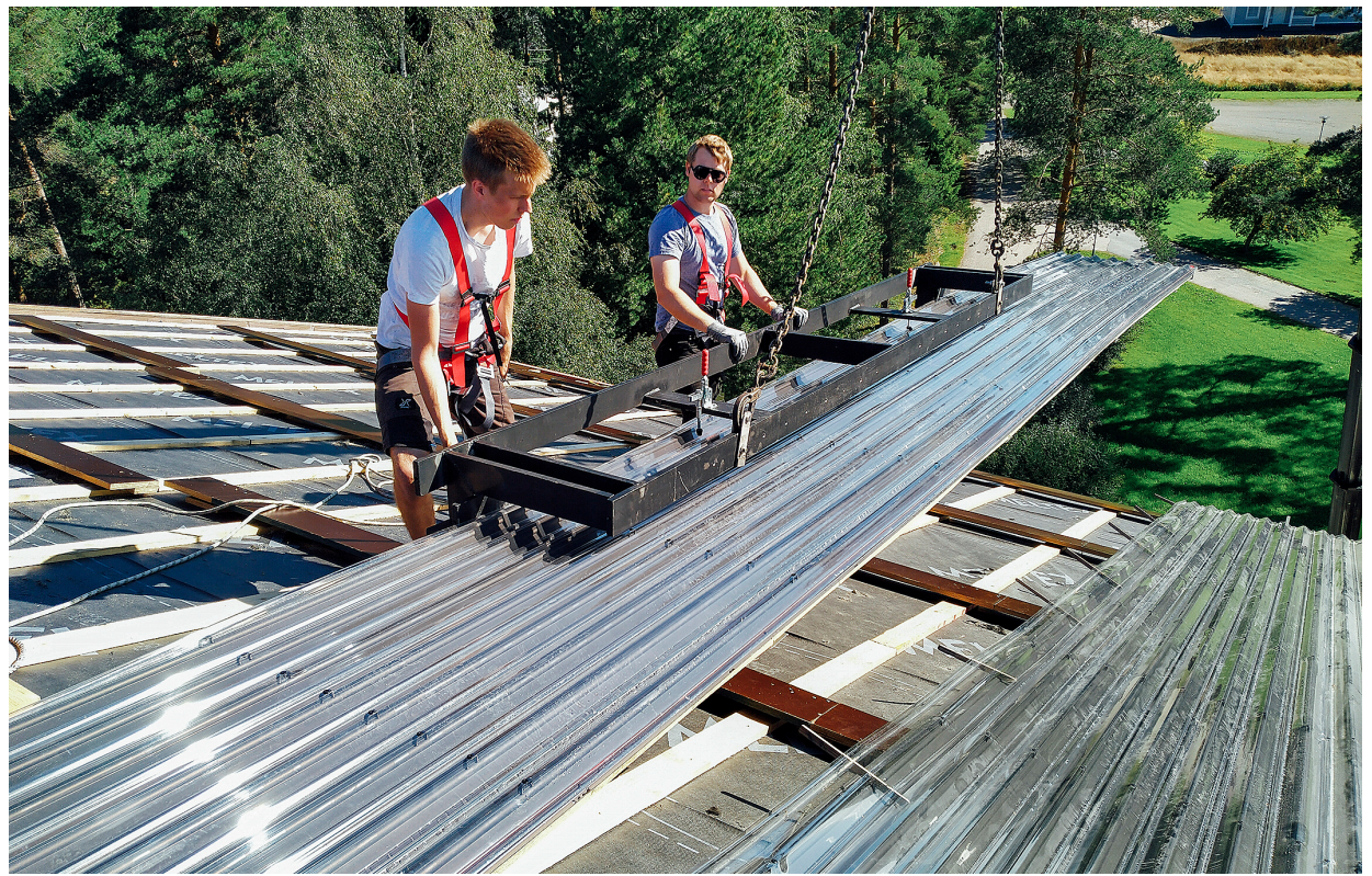
↑ Aurinkokeräinkatto toimii sekä vesikattona että aurinkokeräimenä.
