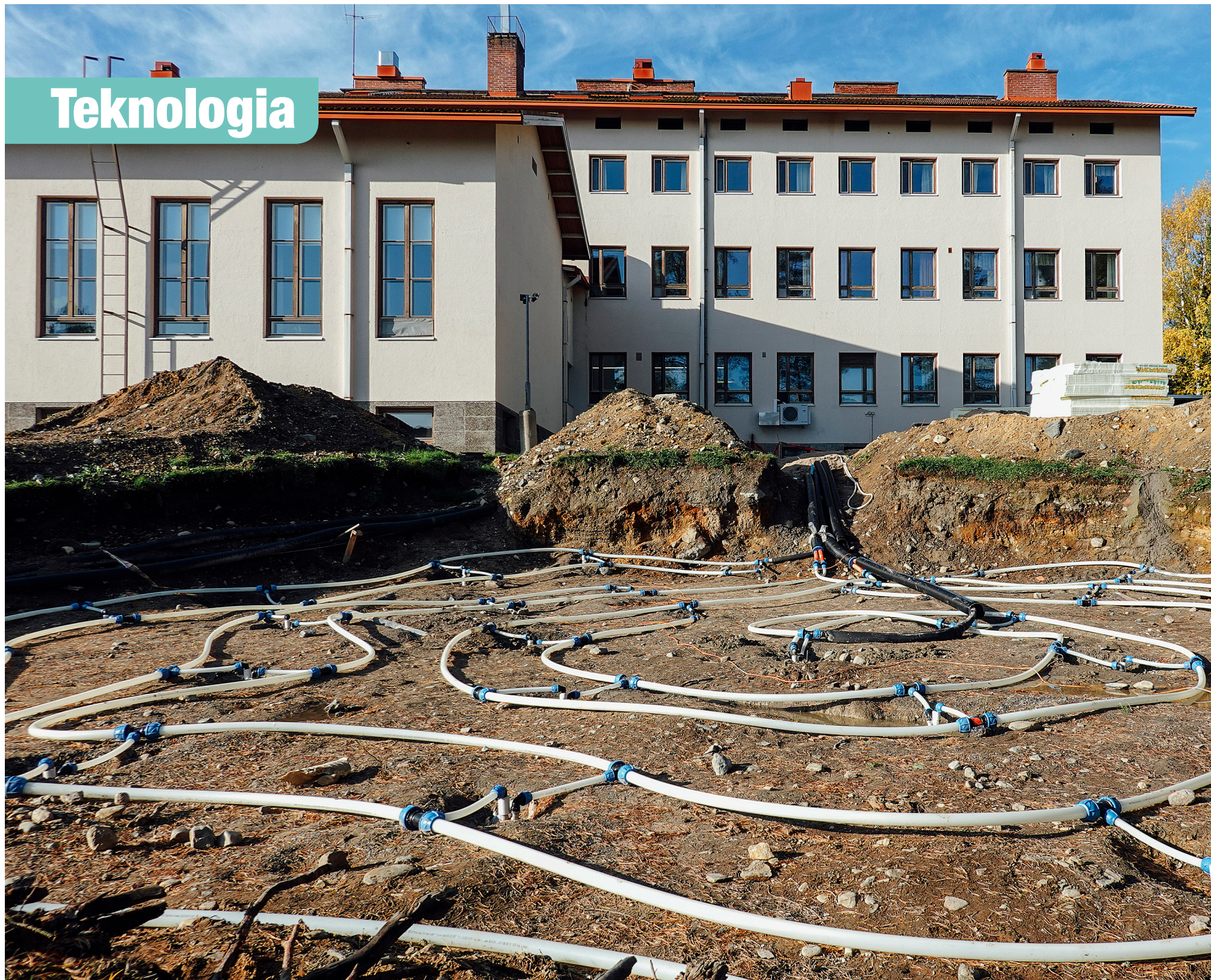
↑ Kaustisen Evankelisen opiston järjestelmässä on 600 neliötä aurinkokeräinkattoa ja 37 kaivon lämmön kausivarasto. Kuvat Heliostorage
