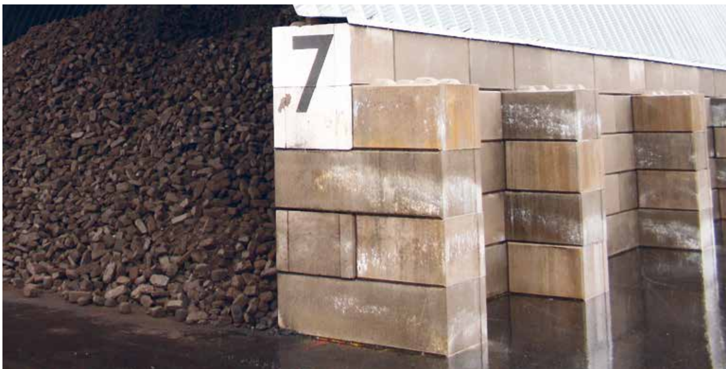
↑ Sokkeli on tehty 640 kilon "legopaloista".
