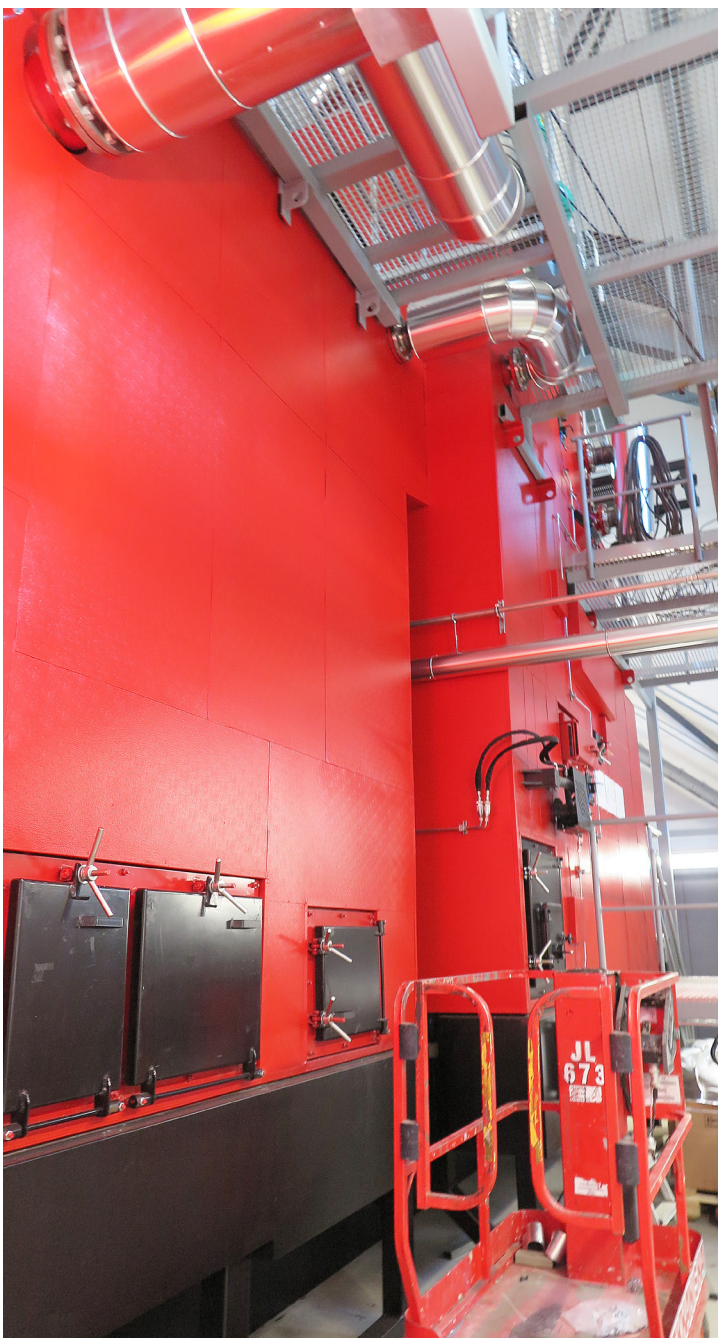
↑ Kattila rakennettiin Tampereella ja tuotiin kolmessa osassa paikan päälle.
