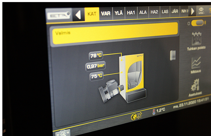
↑ Savukaasun lämmöt olivat vanhassa järjestelmässä jopa 300 astetta, mutta nyt ne ovat tippuneet 80 asteen paikkeille.
