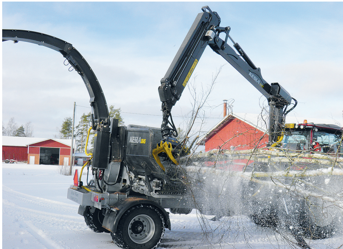
↑ Tuulettuvalle paikalle sijoitettu puupino on tärkeä laadukkaan hakkeen tekijä, puhtautta unohtamatta. Giljotiiniterällä varustetuilla kaivureilla nostellaan helposti puut juurineen, mikä on myrkyä hakkurin terille.
