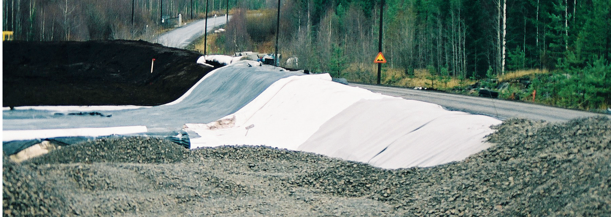
↑ Varkauden ongelmajäte -kaatopaikan pohjarakennemateriaaleja. Kuva: Ilkka Ilmavirta
