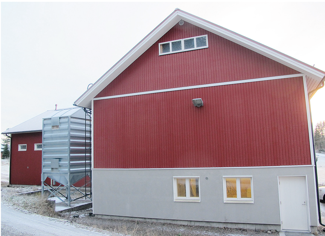
↑ Varastona toimineen entisen sikalan paikalle rakennettiin 400 neliömetrin huoltorakennus.
