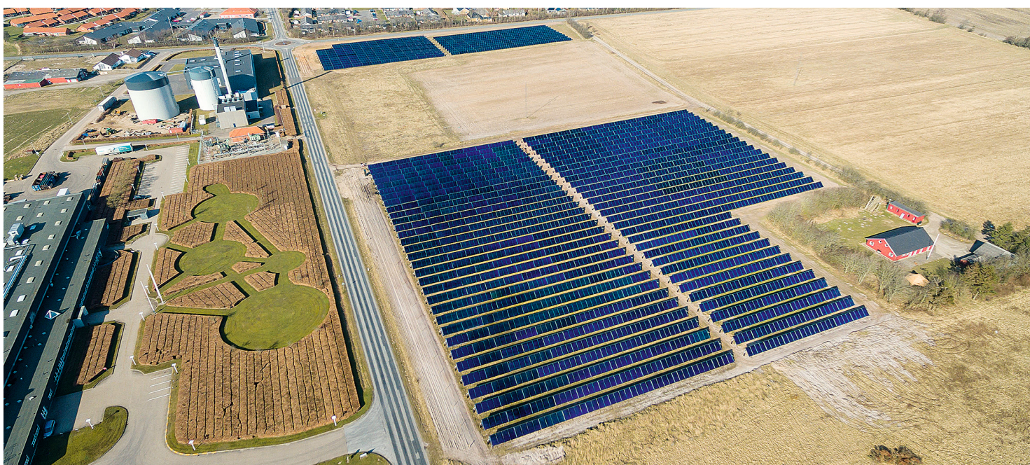
↑ Løgumklosterin kaukolämpölaitoksella lämmöntuotanto perustuu Savosolarin aurinkolämpökeräimien tuottamaan lämpöön, bioenergiaan ja maakaasuun sekä lämpöpumppujen hyödyntämiseen.
