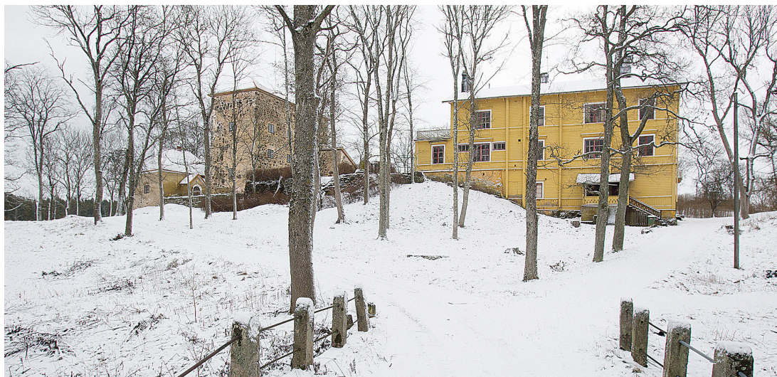
↑ Qvidja Kraft on vuokrannut tontin Qvidjan kartanolta. Qvidja Kraftille rakennetaan bioenergiailaitoskonaisuus sekä tuotanto- ja toimistotilat. Bioenergiailaitoskokonaisuuden muodostavat bio- ja puukaasulaitos, hakelämpölaitos ja metanointilaitos. Qvidjan kartanolle rakennetaan eläinsuojia noin sadalle luonnonlaitumella laiduntavalle naudalle sekä rehu- ja lantavarastot.
