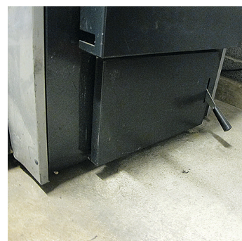
↑ Pellettikattilassa pitää olla kunnan luukku, jonka kautta tuhkat poistetaan.
