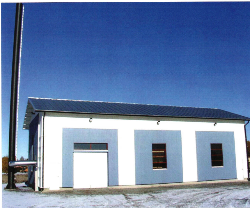
Vöyrin Tulostekniikalta ostama kaukolämpölaitos joka on ollut toiminnassa syyskuusta lähtien.
