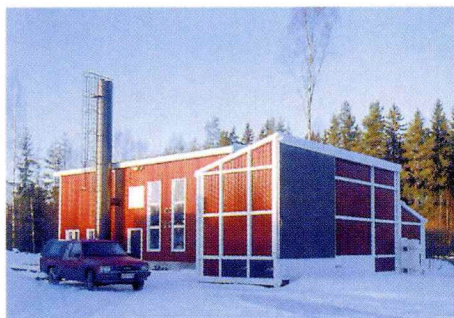
Porin Metsäopisto 1 MW, kaukolämpölaitos
