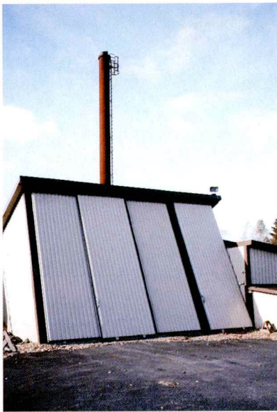
Hakesiilon edessä on puhtaanapidon kannalta tärkeätä saada asfalttipinta. Takana näkyy osa varsinaisesta lämpökeskuksesta ja vieressä kuvan ulkopuolella on varmuusvarasto.
