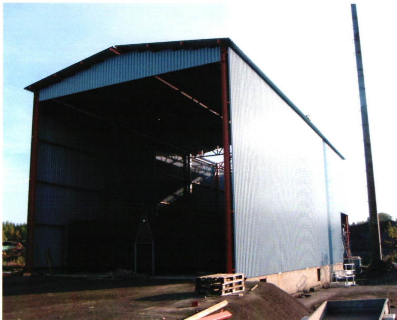
Uusi vastaanottoasema ottaa vastaan 140 i-m3 puuta tunnissa peräpurkulaiteella varustetulta kuorma-autolta tai korkeintaan kahdeksaan metriin kippaavalta vaunulta.
