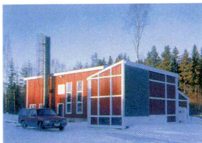
Porin Metsäopisto / MW, kaukolämpölaitos
