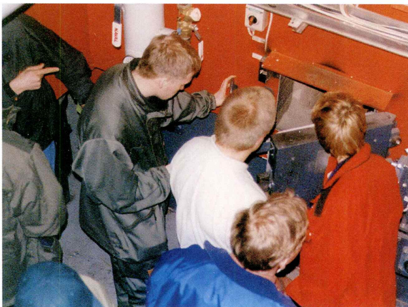
Saarijärven Kolkkanrinteen vanhainkodin hakelämpölaitoksen kattilatekniikka kiinnostaa energiapuuneuvojakurssilaisia.
