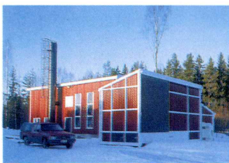
Porin Metsäopisto / MW, kaukolämpölaitos
