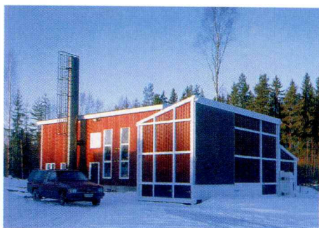
Porin Metsäopisto / MW, kaukolämpölaitos
