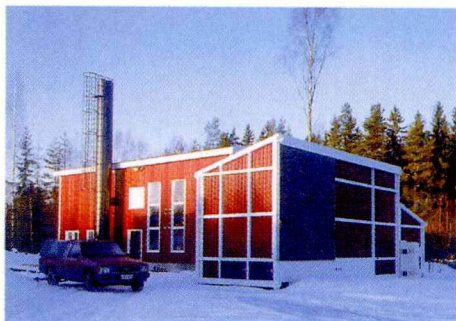
Porin Metsäopisto / MW, kaukolämpölaitos
