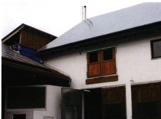
← Maatilan rakennusten katoilla oli useaan ilmansuuntaa asennettu aurinkosähkökennot.
