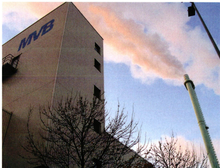
↑ Kierrätyspuuta käyttävän laitoksen vierestä samalla tontilla löytyy jätteenpolttolaitos, joka vuodessa polttaa yli 300 000 tonnia jätettä.
