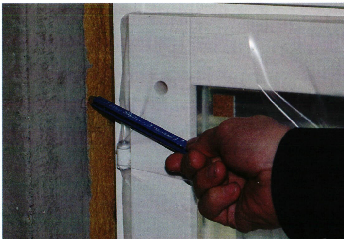
↑ Bioenergiakeskuksessa testataan erilaisia eristysratkaisuja. Kuvassa polyuretaani
