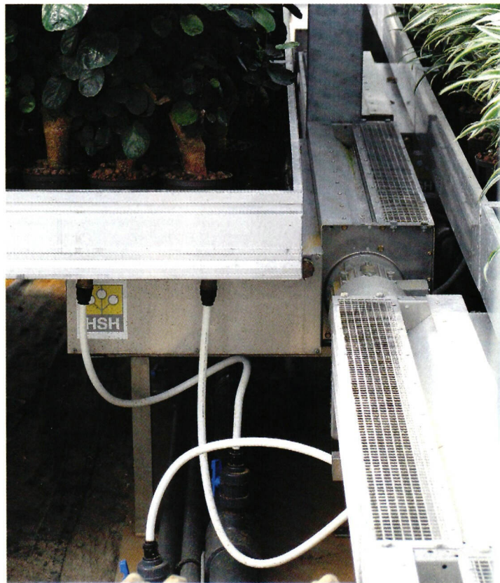
↑ → Lämmönvaihtimet kuvattuina etupuoelta ja ylhäältä. Normaalisti ne ovat kasvien ja altaiden välissä. (Kuvat: Theo Eeuwes)
