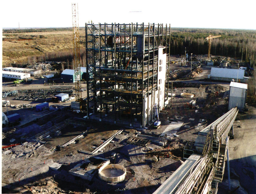
↑ Porin Prosessivoima Oy:n voimalaitoksen rakennustyöt käynnistyivät talvella 2007. Porin Prosessivoima Oy:n voimalaitostyömaan työllisyysvaikutus on noin 100 henkilötyövuotta. Investoinnin arvo on noin 240 miljoonaa euroa. Kuvassa kattilalaitoksen runko. Kuva: Mikko Heikkilä
