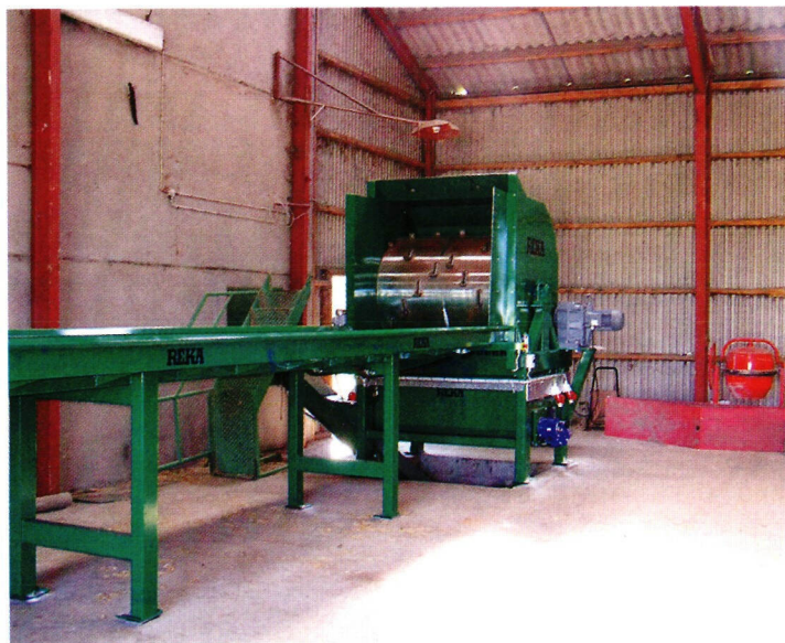
↑ Kokkola Energia Oy:n linjasto on ennätyspitkä.
