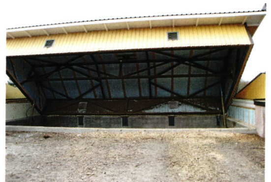
↑ Vehmaa Energian lämpölaitoksen laajennus saatiin käyttöön alkuvuodesta. Urakoitsija täyttää rakennuksen keskellä olevaa hakevarastoa 50–60 kuution kuormin parin päivän välein. Kovimmilla pakkasilla polttoainetta kului noin 50 kuutiota vuorokaudessa.
