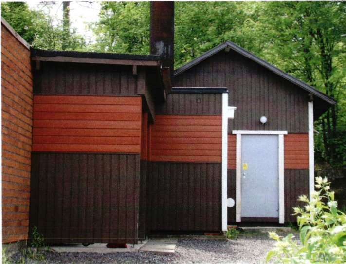
↑ Rinnetien Lämpö Oy:n pannuhuone ja pellettivarasto.
