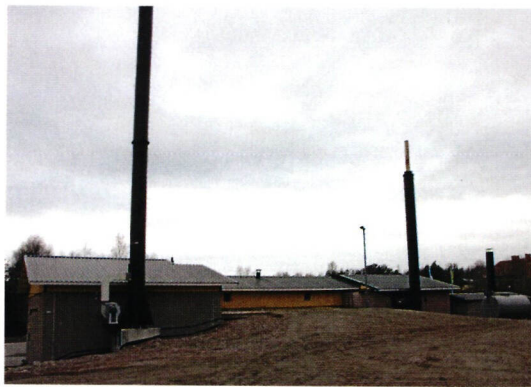
↑ Vehmaa Energian lämpölaitoksen laajennus saatiin käyttöön alkuvuodesta. Urakoitsija täyttää rakennuksen keskellä olevaa hakevarastoa 50–60 kuution kuormin parin päivän välein. Kovimmilla pakkasilla polttoainetta kului noin 50 kuutiota vuorokaudessa.
