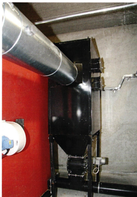
← ↑ Tuubeissa olevia nuohojinruuveja käytetään samanaikaisesti yhdellä sylinterillä. Lentotuhka menee sulkusyöttimen kautta tuhkaruuville. Tuhkanerotin toimii Topi Pämmin mielestä niin hyvin, että multisykloni voikin jäädä tarpeettomaksi.
