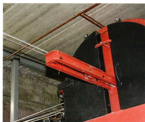
← ↑ Tuubeissa olevia nuohojinruuveja käytetään samanaikaisesti yhdellä sylinterillä. Lentotuhka menee sulkusyöttimen kautta tuhkaruuville. Tuhkanerotin toimii Topi Pämmin mielestä niin hyvin, että multisykloni voikin jäädä tarpeettomaksi.
