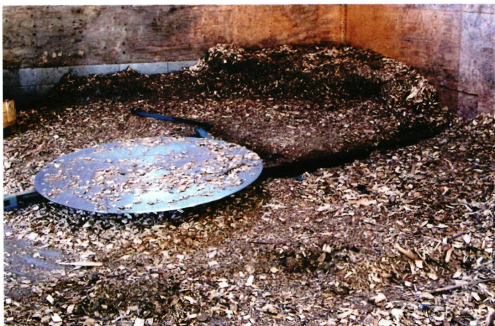
↑ Toimitilat ja hallit lämpiävät hakkeella, jota kuluu 600–700 kuutiota vuodessa. Toimintavarmen saksalaisen hakekattilan yksityiskohtia on yksinkertainen syöttölaite.
