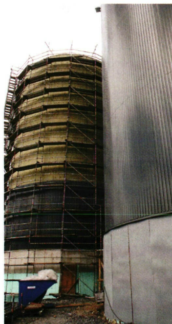
↑ Lautupäällikkö Anu Sivonen on tyytyväinen laitoksen hygienisointityksiköistä. Säiliöissä yli tunnin ajan yli 70 asteeseen kuumentamalla mädäte on taatusti puhdasta ja turvallista lannoitetta.
