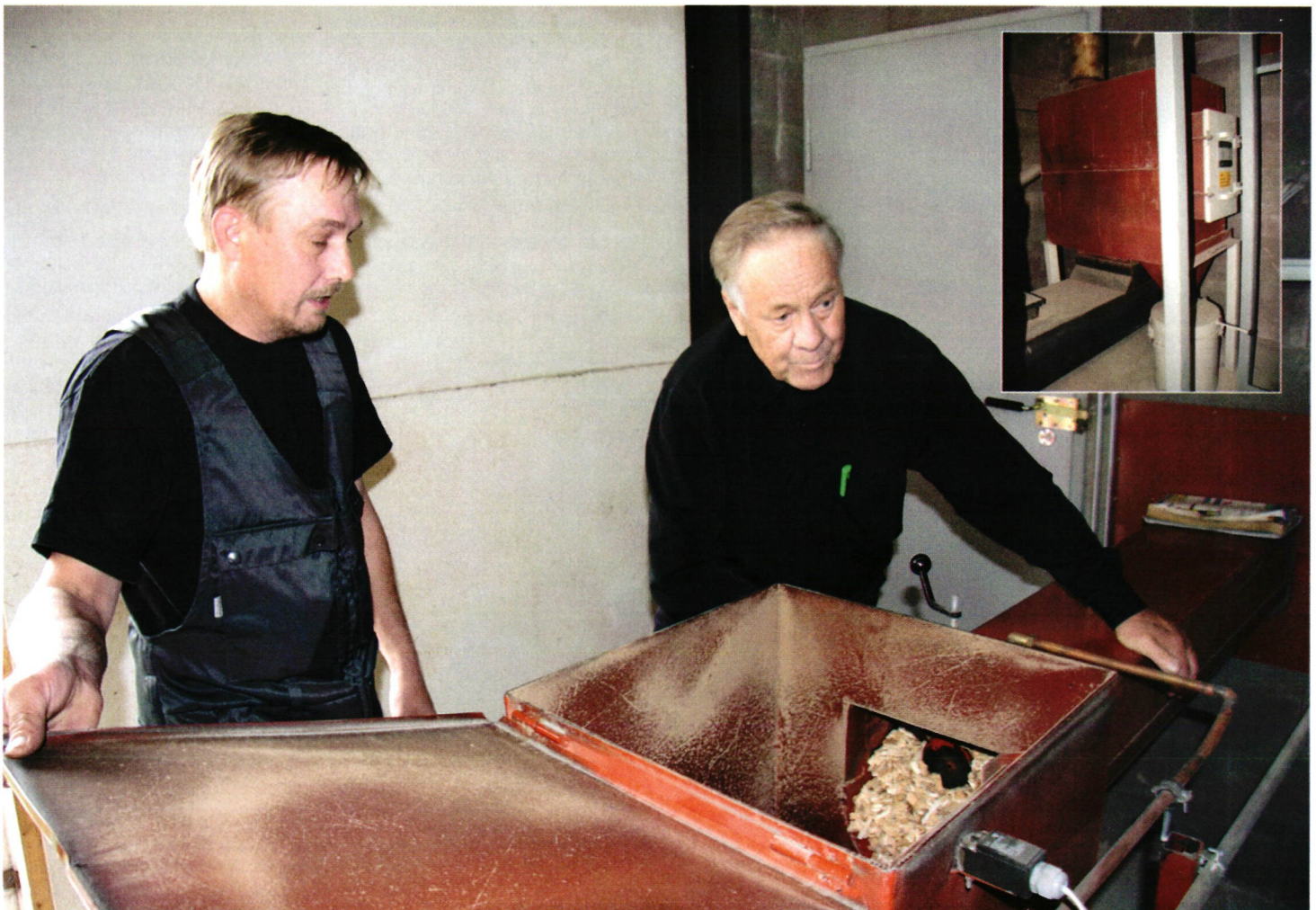
↑ Sauli (vas.) ja Ilkka Alsila ovat olleet tyytyväisiä hakelaitokseensa. Ruuvit eivät ole menneet tukkoon kertaakaan. Ensimmäisenä lämmityskautena käytetty hake oli liian kosteaa, ja suurten hiukkaspäästöjen vuoksi savukaasupuhdistimen sykloni meni tukkoon.
