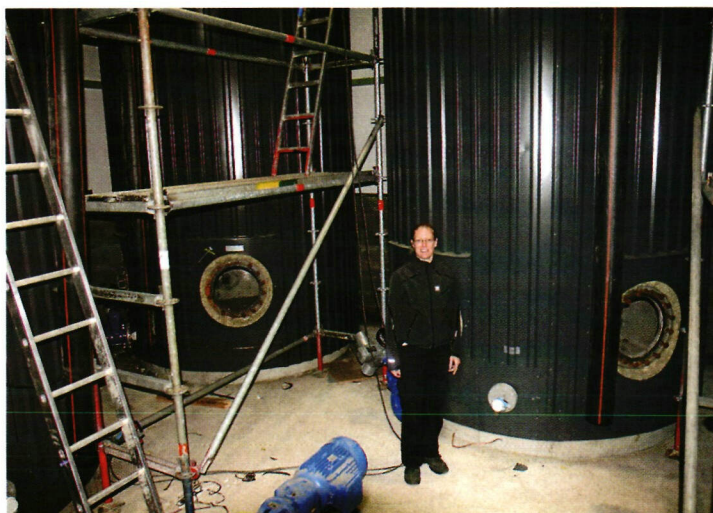
↑ Lautupäällikkö Anu Sivonen on tyytyväinen laitoksen hygienisointityksiköistä. Säiliöissä yli tunnin ajan yli 70 asteeseen kuumentamalla mädäte on taatusti puhdasta ja turvallista lannoitetta.
