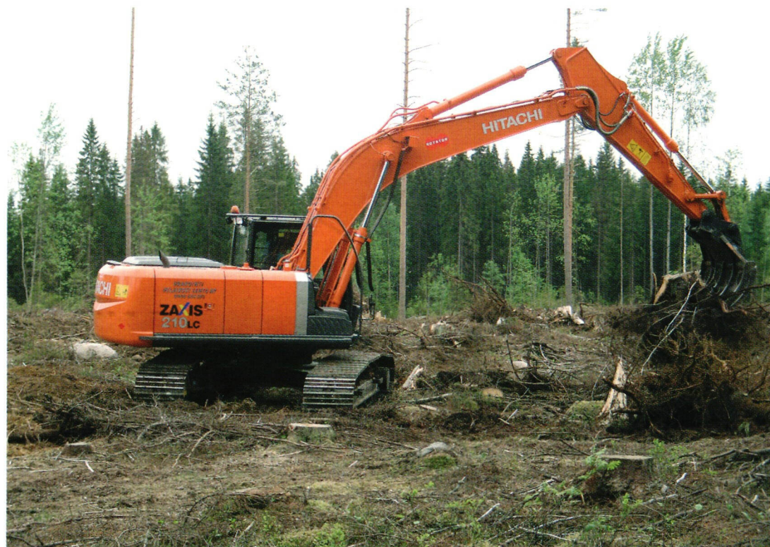
↑ Kantojen nostovolyymit ovat kasvaneet merkittävästi viime vuosien aikana; kuluneen kesän aikana kantoja nostettiin runsaalla sadalla kaivukoneella. Kuvassa kantojen nostoa Hitachi Zaxis 210LC -kaivukoneella; käytettävässä nostolaitteessa ei ole leikkaavaa tai puristavaa vastaterää. Valokuva: Metsäteho Oy.
