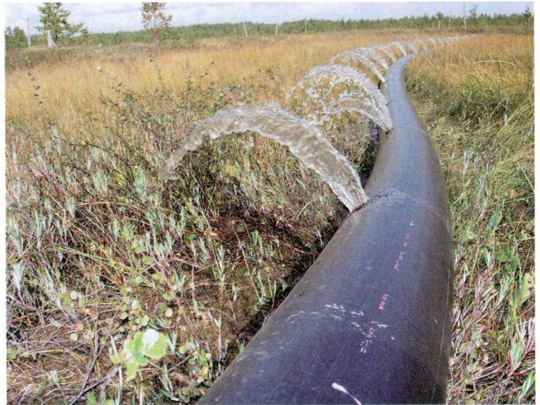
Parkkisenrimmellä laskeutusaltaasta vesi pumpataan reikäputken avulla tasaisesti pintavalutuskentälle.
