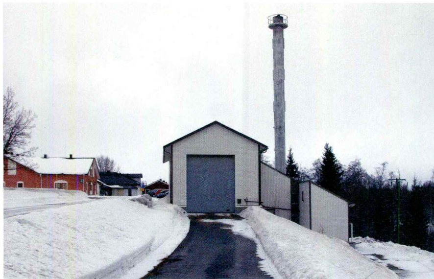
Uudessa Valamossa on noin kaksi kilometriä kaukolämpöverkkoa. Lämpökeskus tuottaa patteriverkossa kiertävän veden ja lämpimän käyttöveden, jota tarvitaan myös kesäisin sen ver- ran, että lämpökeskus on päällä ympäri vuoden.
