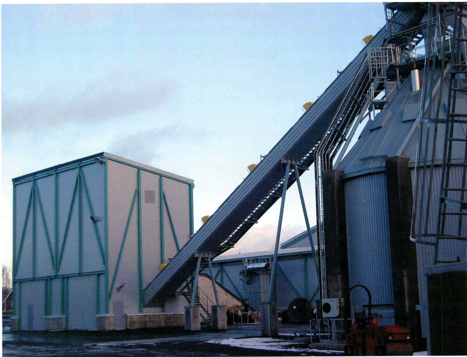
Polttoainetta otetaan vastaan kahdessa hallissa. Edessä olevaan halliin otetaan vastaan kipattavat kuormat ja takana olevaan peräpurkulaitteilla varustetut autot.
