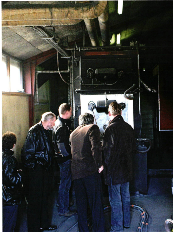
↑ Palaa se, olki, totesi suomalainen retkikunta tanskalaisella broileritilalla. Kattilan nimellisteho on 750 kilowattia.
