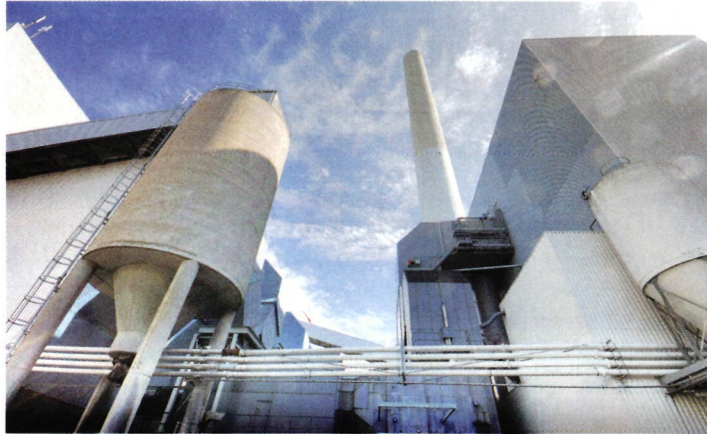
↑ Olkisilpun pneumaattiset siirtolinjat murskaimelta kattilaan Studstrupin voimalaitoksella. Murskaimen pohjaseulan reikien koko on 40 millimetriä, joten keskimääräinen silpunpituus on arviolta 15–20 millia. Kuva: Samuli Rinne
