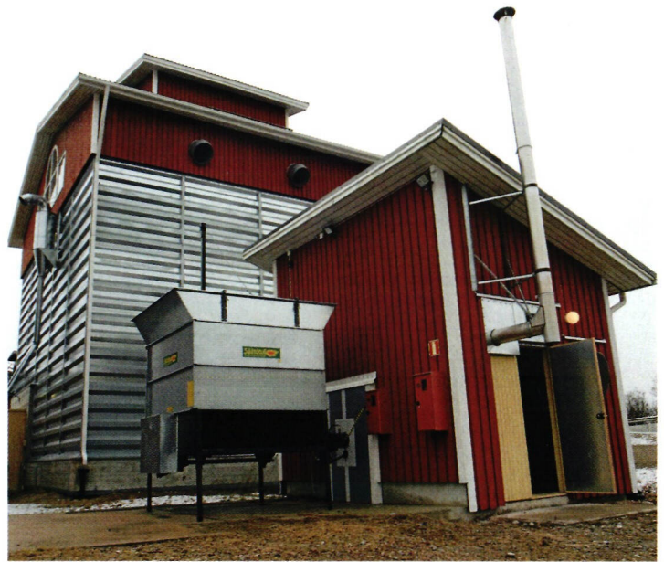
↑ Suupohjan Ammatti-instituutin hakekäyttöinen kuivaamo on ollut käytössä neljänä syksynä.
