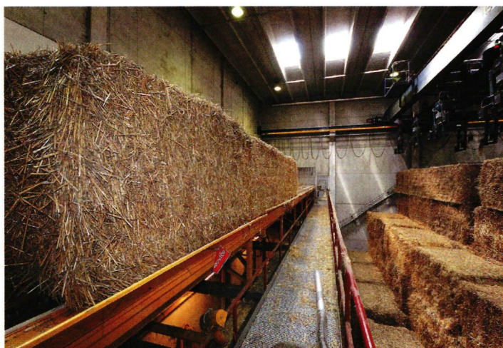
↑ Olkipaaleja Dong Energy'n Studstrupin voimalaitoksen paaliradalla menossa murskaukseen. Oikealla näkyvät paalinosturit. Rekkoja purettaessa nosturien pihdeissä olevat anturit mittaavat paalien kosteuden mikroaaltotekniikkaan perustuen. Kuva: Samuli Rinne
