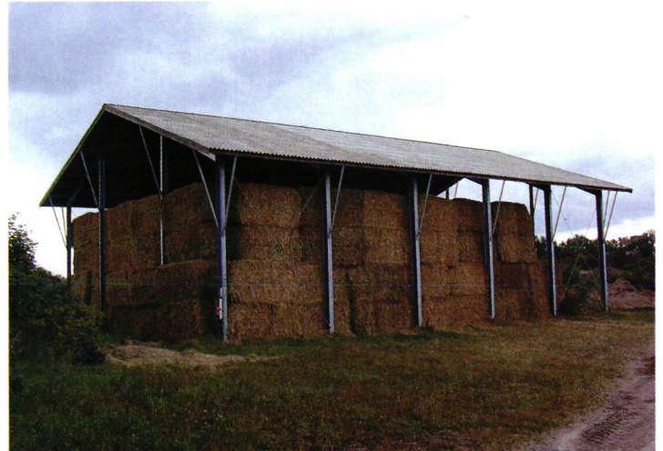
↑ Tanskalaistiloilla poltettavat olkipaalit pyritään varastoimaan katoksissa, sillä varastointi pressujen alla on epävarmaa ja työlästä. Seiniä ei välttämättä tarvita.
