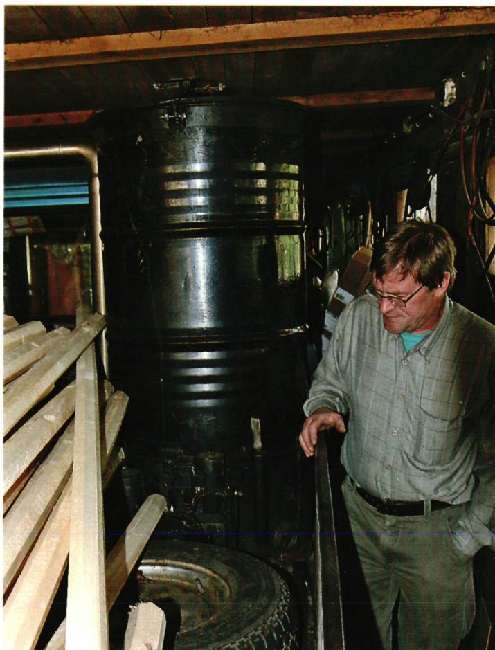
↑ Polttoaine tankataan Transitin tankkiin, jossa se kaasutetaan.
