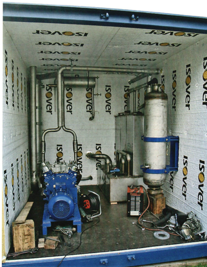
↑ Kontin sisältä löytyvät kaasunpuhdistin ja lukuisa joukko lämmönvaihtimia. Moottorin pakokaasuista ja jäähdytysvedestä otetaan lämmöt talteen. Mopa V-8 -moottori pyörittää 15 kilowatin oikosulkugeneraattoria. Tehoa saadaan ulos pyöreästi 50 kilowattia, josta 15 sähköä.
