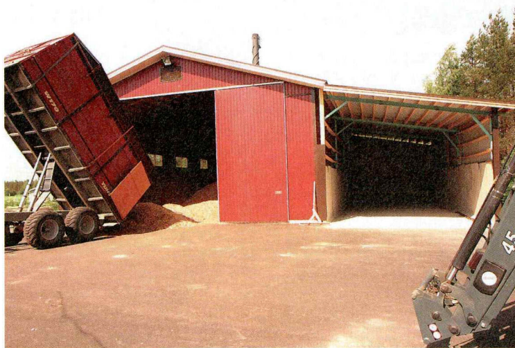
Polttoainetta mahtuu tankopurkainten päälle 500 - 600 kuutiota, mikä riittää pakkasilla vajaan kahden viikon ajaksi. Varastolaajennuksen ansiosta kapasiteetti kasvaa 1 000 kuutiolla, jolloin polttoainetta on pitkänkin pakkasjakson ajaksi. Luonnollisesti palaturvetta ja brikettejä on käytettävissä silloinkin, kun haketus estyy.
