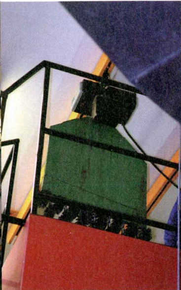
Kattilan konvektiopinnat voidaan puhdistaa koneellisesti vinssin käytämin harjoin. Nuohoukseen kuluu vain parikymmentä minuuttia aiemman kolmen tunnin asemesta.
