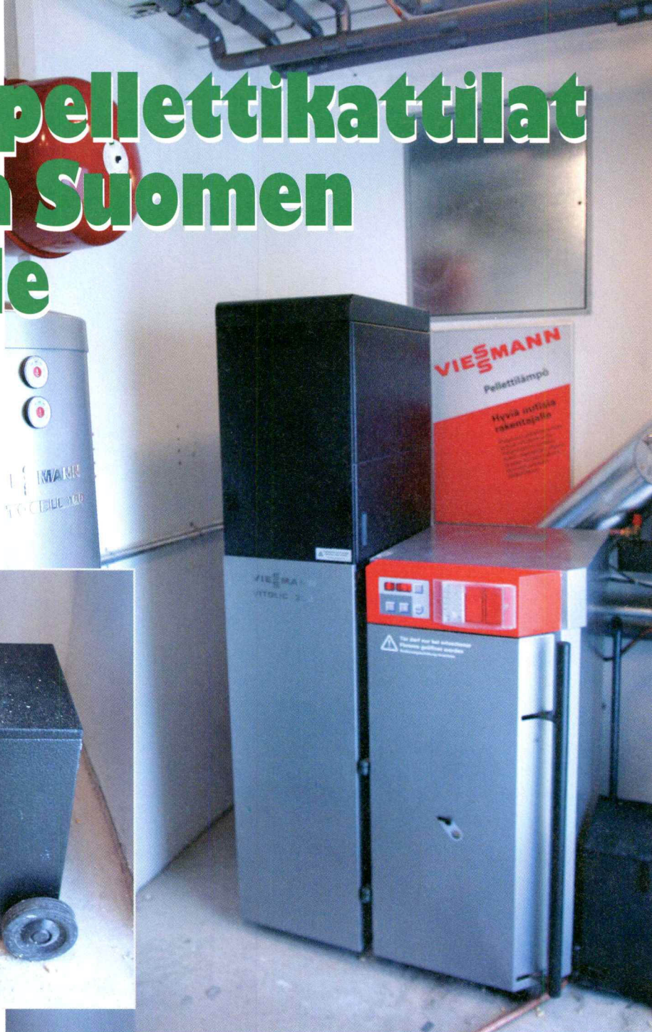
Polttoainesäiliö (vasemmalla) ja kattila polttimineen ovat samaa kokonaisuutta. Ulkoisilta mitoiltaan pieneen tuhkasäiliöön mitä ilmeisimmin mahtuvat 6-7 pellettitonnin palamisjätteet.
