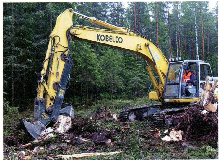
Kantojen nostossa on kehitetty laitteita viime vuosien aikana. Pallarin kantojen nostolaite pilkkoo kannot pienemmiksi ja muokkaa uusia viljelykohtia. Kantoja nostaa yli 10 konetta tänä vuonna.
