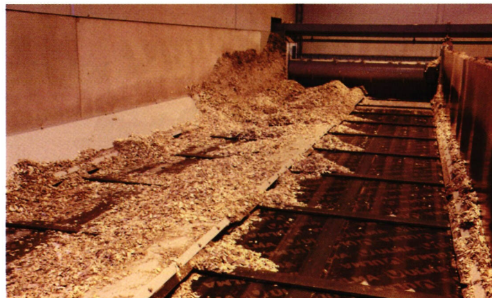
↑ Hakevaraston kolakuljettimet pukkaavat metsähaketta jauhimelle vievälle kuljettimelle.
