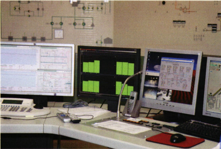
↑ Valvomossa seurataan, kuinka turpeen ja puupölyn seos palaa yhdeksässä polttimessa. Joka polttimelle on oma vihreä palkki kuvaamassa toimintaa.
