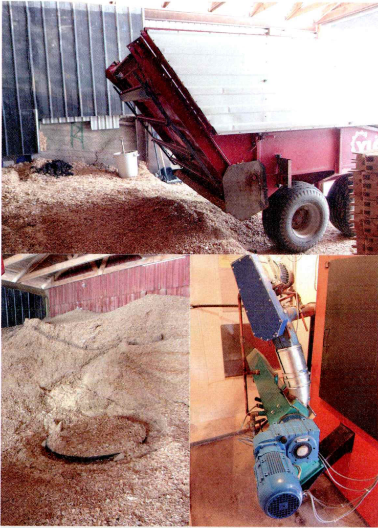
Monitoimiperävaunu sopii oikein hyvin hakkeensiirtoon. Kosteaa hakkeen jäätyminen varastossa on aiheuttanut jonkin verran ongelmia. Polttoaineruuvit yhdistyvät ennen lokerosyötintä, jolloin kosteudeltaan erilaisten polttoaineiden samanaikainen käyttö on helppoa.
