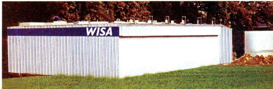
WISA on saksalaisen konsernin kehittämä panosperiaatteella toimiva biokaasulaitos, jonka kokoluokat alkavat 1000 kuutiosta lietelantaa vuodessa.
