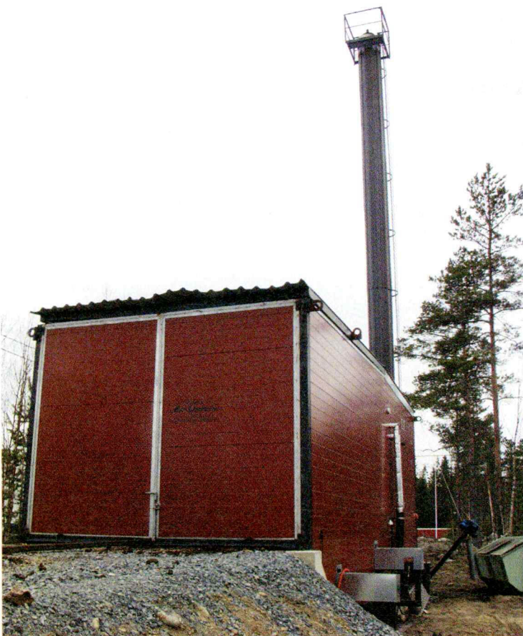
Kontin varasto vetää 40 kuutiota polttoainetta. Kontilta on vedetty 115 metriä lämpökanavaa West Weldingille. Asennuspalvelu Vainionpään kiinteistöön on matkaa alle 50 metriä. Kontin katon nostomekanismiin joudutaan vaihtamaan uudet, vahvemmat sylinterit, jotka kestävät tuulen riepotuksen.
