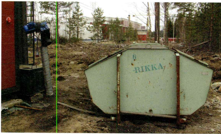
Tuhka siirretään ruuvilla 12 kuution roskalavalle. Lämmityskaudella lava joudutaan tyhjentämään kahdesti, tuhkaa kertyy kaikkiaan 15-20 kuutiota.
