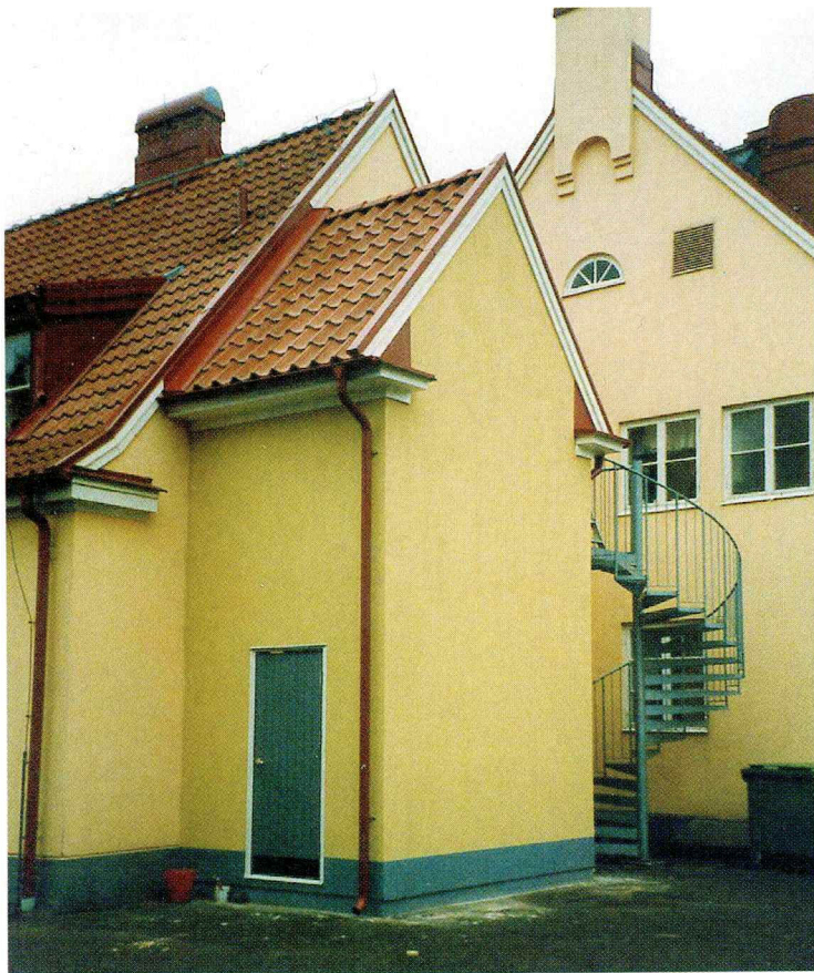
Pellettien varastointi voidaan toteuttaa tyylikkäästi muuhun rakennuksen ympäristöön verhoiltuna pystysilona.
