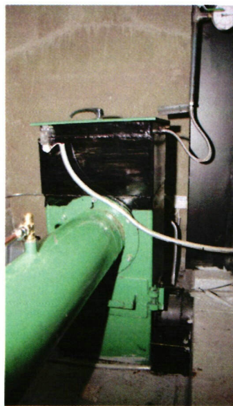
↑ Kattilan palamisilma otetaan välikaton ilmatilasta spiraaliputkilla ja tuodaan palopäähän puhaltimille. Aurinko esilämmittää palamisilmaa keväästä syksyyn.
