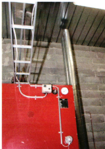
↑ Kattilan palamisilma otetaan välikaton ilmatilasta spiraaliputkilla ja tuodaan palopäähän puhaltimille. Aurinko esilämmittää palamisilmaa keväästä syksyyn.
