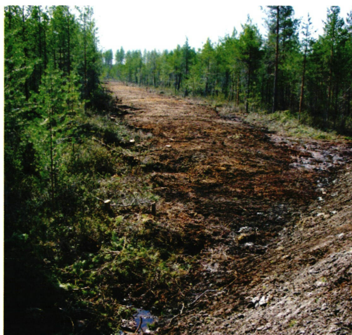
↑ Pintavalutuskentän vesienpuhdistusteho perustuu kentän biologisiin, fysikaalisiin ja kemiallisiin prosesseihin. Pintavalutuskenttä voidaan huolellisella valmistelulla joskus toteuttaa myös ennestään metsäojitetulle alueelle ojia tukkimalla ja mahdolliset oikovalumat estämällä. Kuva: Lauri Ijäs
