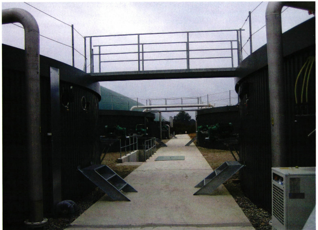
↑ Saksaan on syöttötariffin myötä perustettu biokaasulaitoksia eri kokoluokissa maatilakohtaisista laitoksista suuriin yhteiskäsitteilylaitoksiin. Kuvassa Laupheimissa sijaitseva laitos, jossa tuotetaan 21 viljelijän energiakasveja vuosittain 2,8 milj. m 3 biometaania kaasuverkkoon syötettäväksi. Laitoksen kaasuntuotto vastaa nykyään 600 kW:n sähkötehoa, ja suunnitellun laajennuksen jälkeen 1 MW:n sähkötehoa. (Kuva: Eeli Mykkänen)
