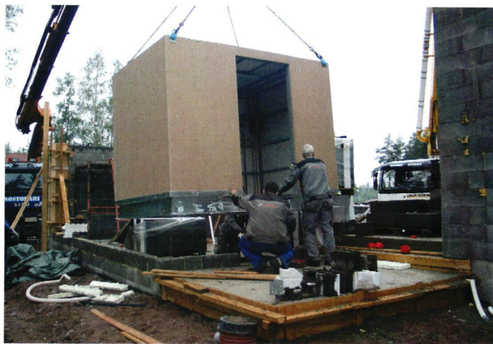
↑ Lämmitystilayksikkö tuodaan työmaalle kerta-toimituksena ja se asennetaan paikoilleen yhdellä nostolla. Kuva: TT-Group Oy
