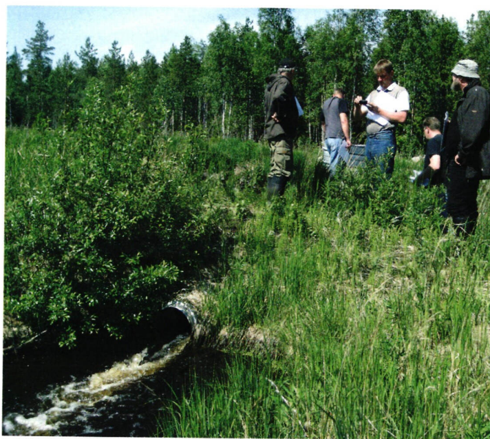
▲ Pumppu nostaa veden pumppauskaivosta jako-ojaan. Kuva: Ari Erkkilä
